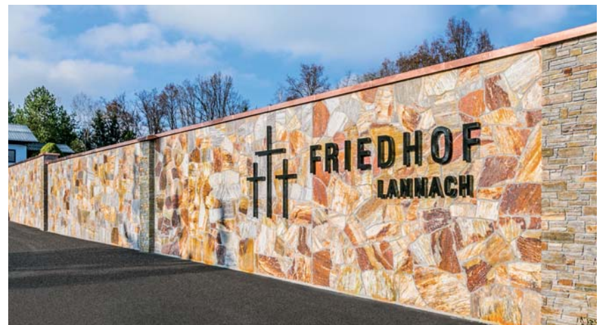
2014: Friedhof – Außengestaltung und Parkplatzerrichtung.
