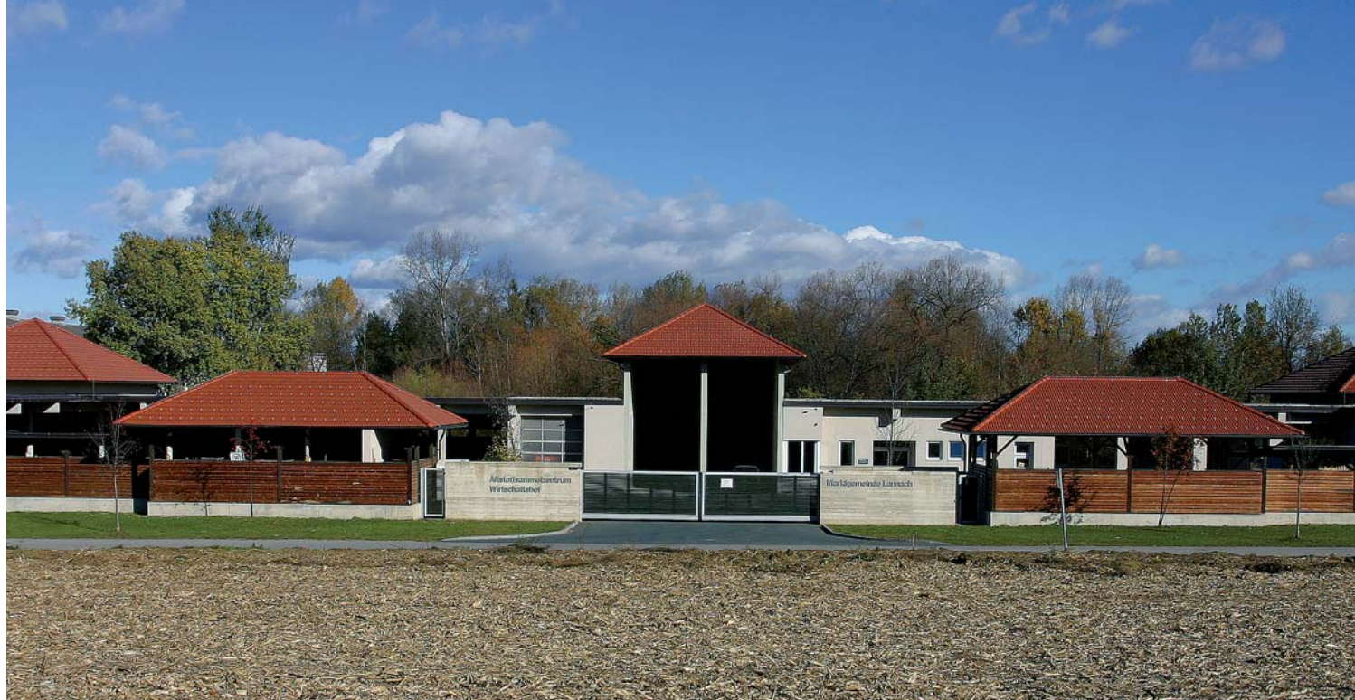
2001: Wirtschaftshof und Abfallsammelzentrum, wichtige Bestandteile der kommunalen Infrastruktur.
