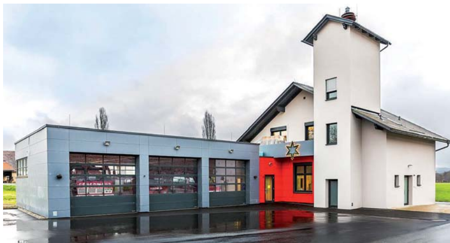
2014: Spatenstich (oben) zum Rüsthauszubau der FF Breitenbach-Hötschdorf (unten).
