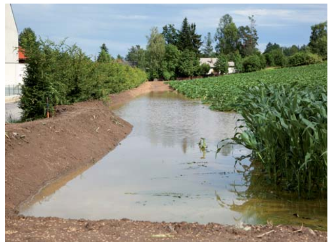
2011: Am Fischerweg wurde ein Hochwasserdamm errichtet.
