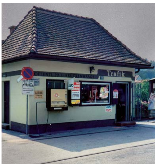
2002: Das alte Trafikhäuschen nahe dem Bahnübergang.
