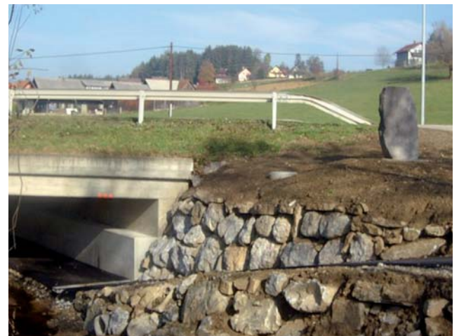
2006: Bei der Teiplbrücke der LB76 wurde eine Fußgängerunterführung errichtet.
